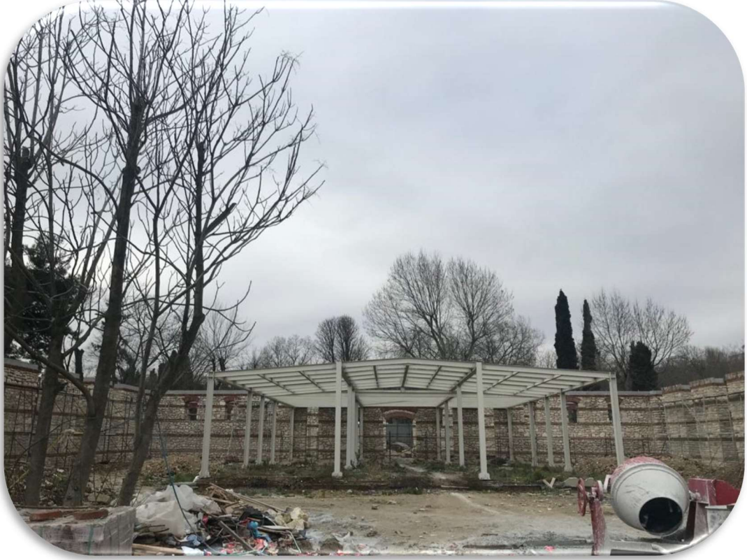
YTÜ DAVUTPAŞA KAMPÜSÜ MİSAFİR HANE BİNASI RESTORASYONU YAPIM İŞİ
