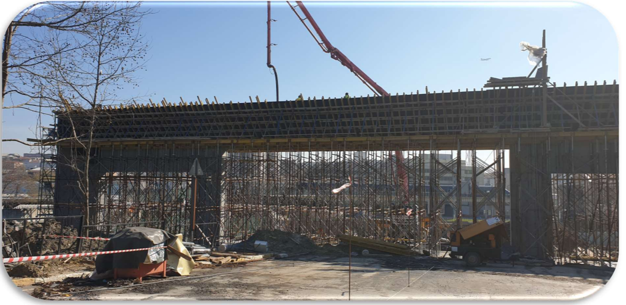
DAVUTPAŞA KAMPÜSÜ GİRİŞ KAPISI YAPIM İŞİ
