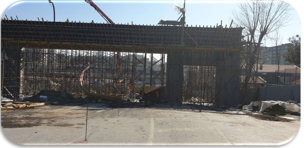
DAVUTPAŞA KAMPÜSÜ GİRİŞ KAPISI YAPIM İŞİ
